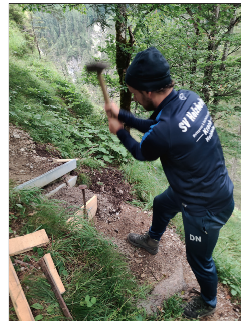
Erneuerung von Stufen am Dillinger Weg
